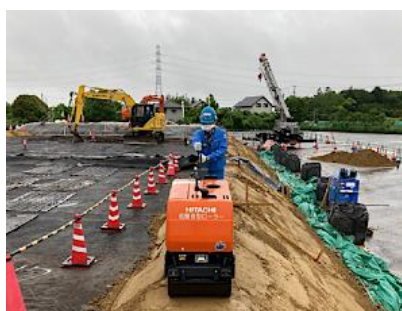
中間貯蔵施設内での実証事業風景 法面部の覆土作業状況 環境省 HP (撮影日 2023 年 6 月 13 日)
